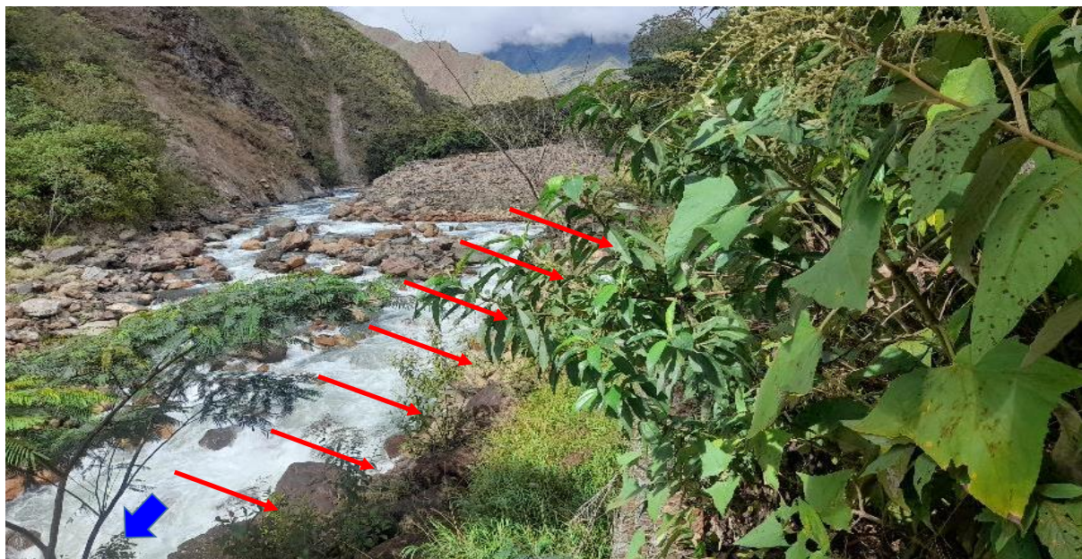
FIGURA N°02: TRAMO DE DEFENSA RIBEREÑA COLAPSADO POR EROSION MARGINAL PROGRESIVA.
