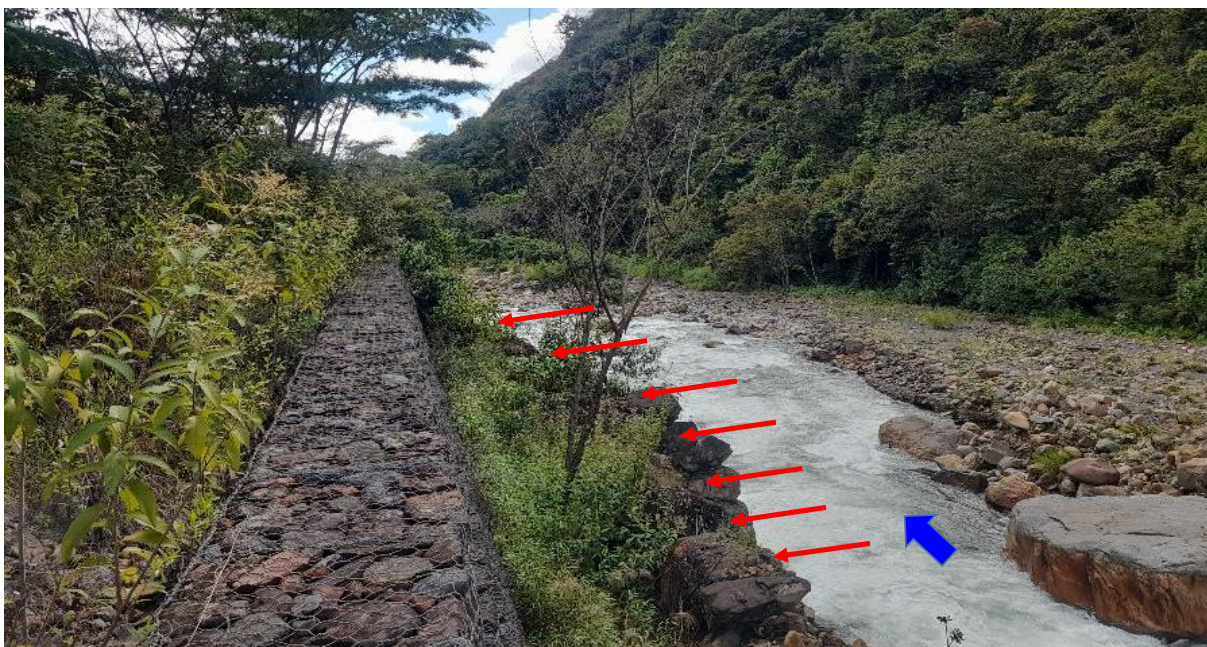
FIGURA N°03: TRAMO DE DEFENSA RIBEREÑA COLAPSADO POR EROSION MARGINAL PROGRESIVA.
